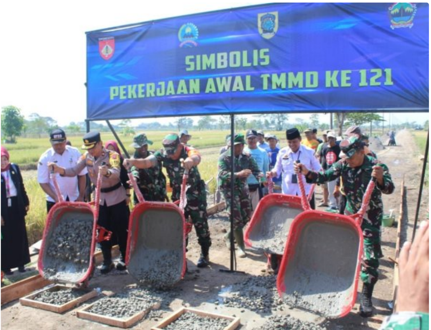
Pengecoran Perdana TMMD Reg 121 dilakukan Forkopimda Klaten
