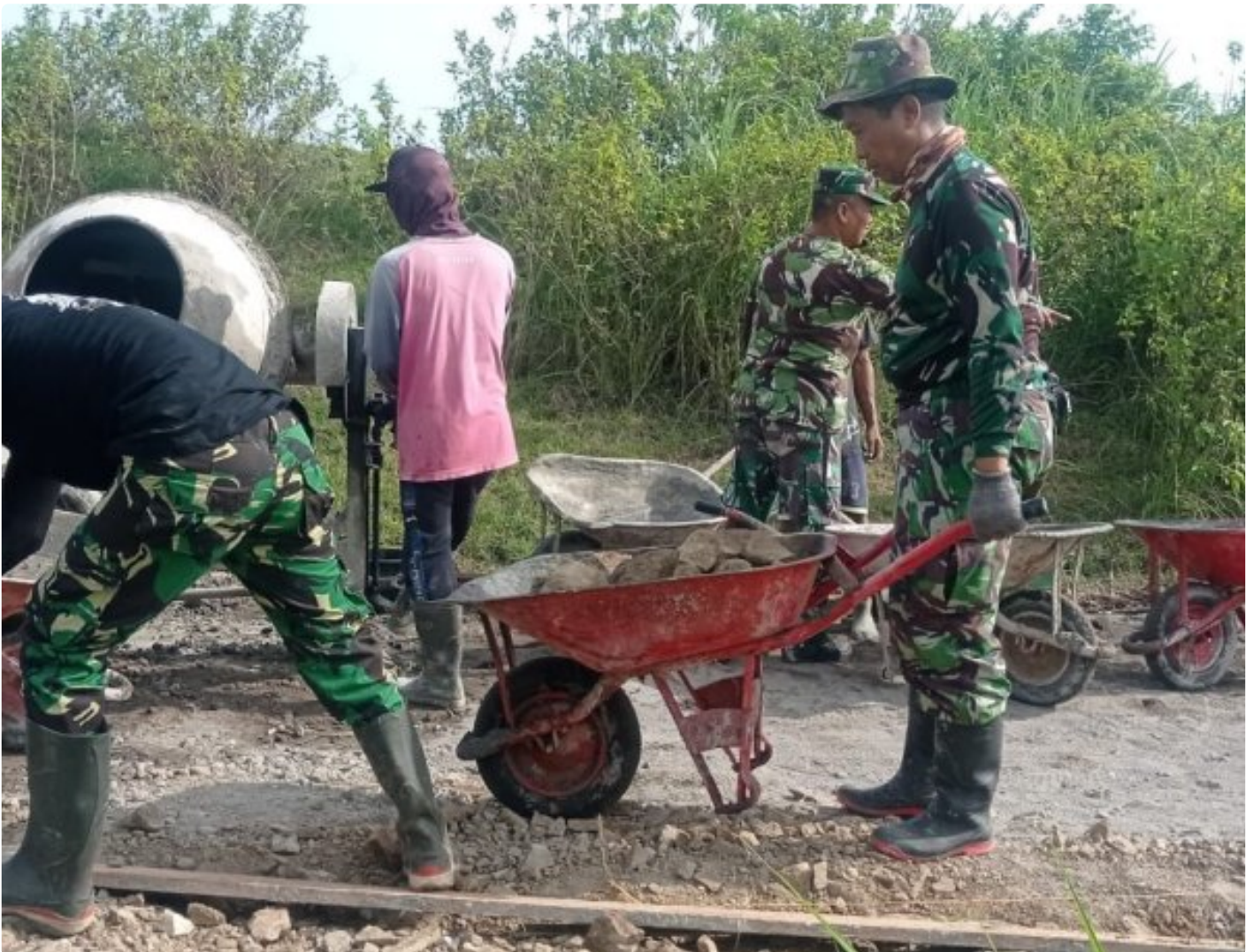
Program TMMD Sengkuyung Tahap I TA 2025 Desa Krakitan Bayat Klaten Mulai Betonisasi
