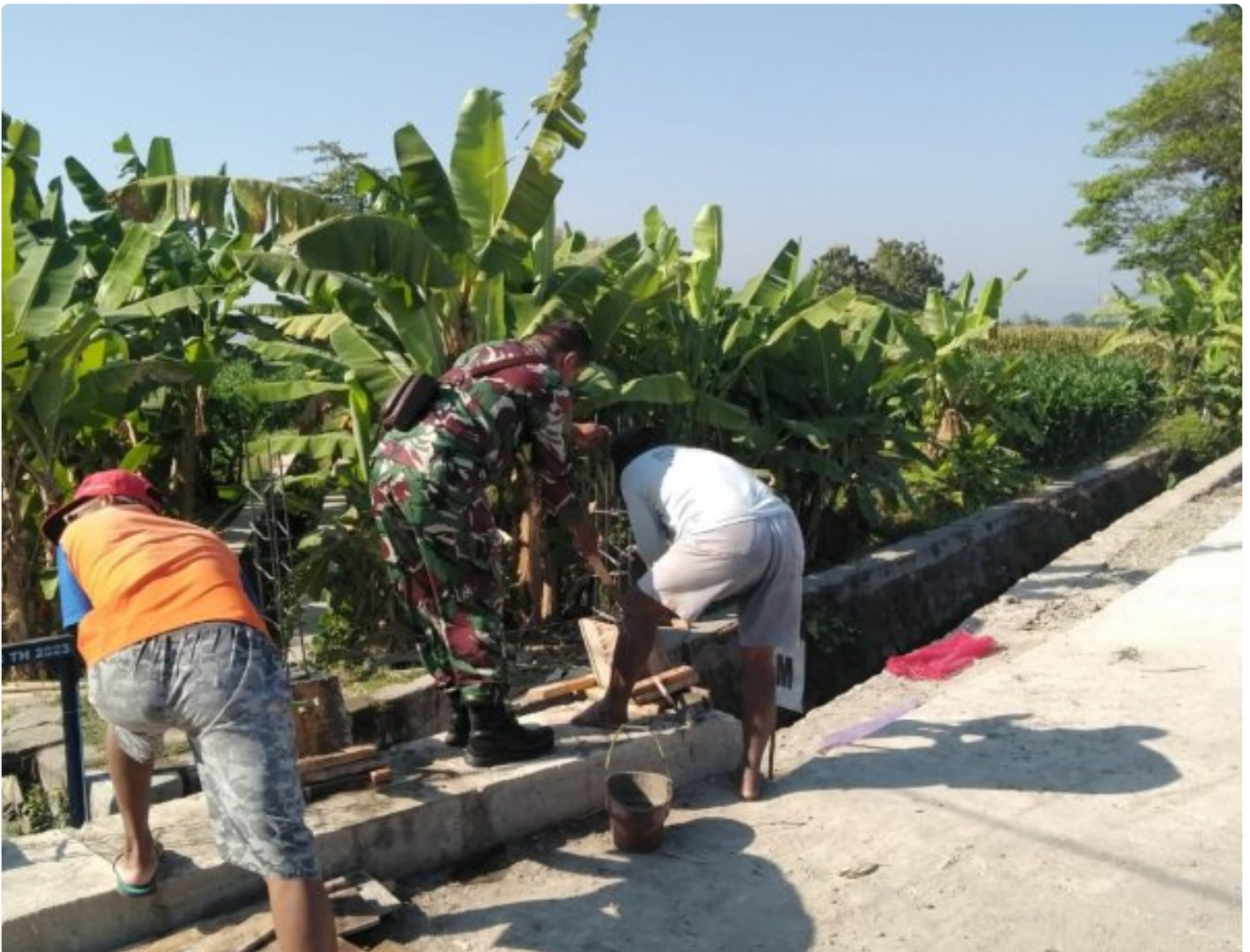
Tahap Finising Jembatan TMMD Reg 121 Kodim Klaten
